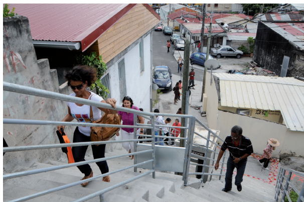
Réhabilitation et aménagement des accès
