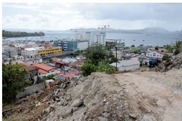
Travaux de désenclavement de Morne Abélard
