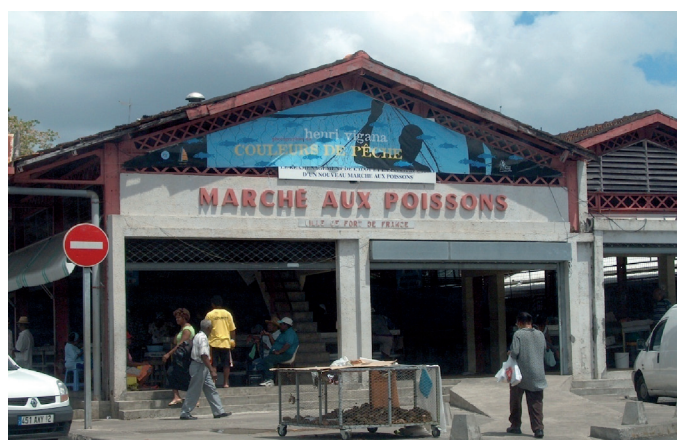
Marché aux poissons avant travaux
