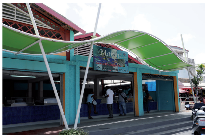
Marché aux poissons après travaux
