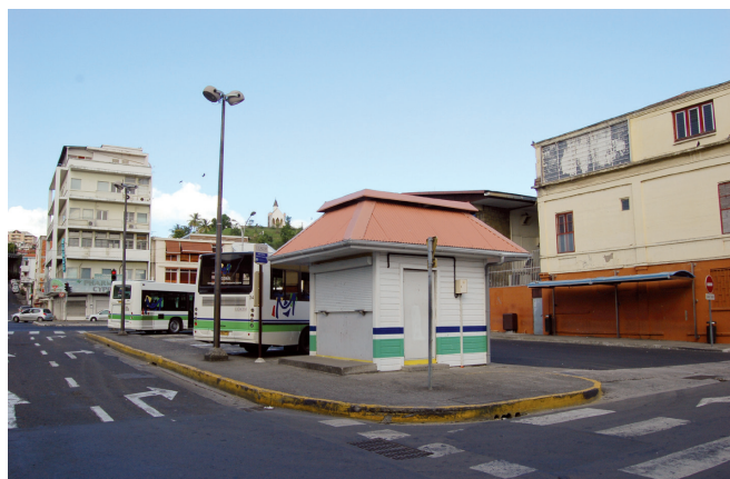
Réaménagement de la Place Nardal
