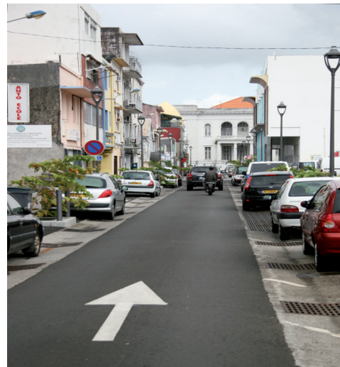
Réfection de la rue Jacques Cazotte
