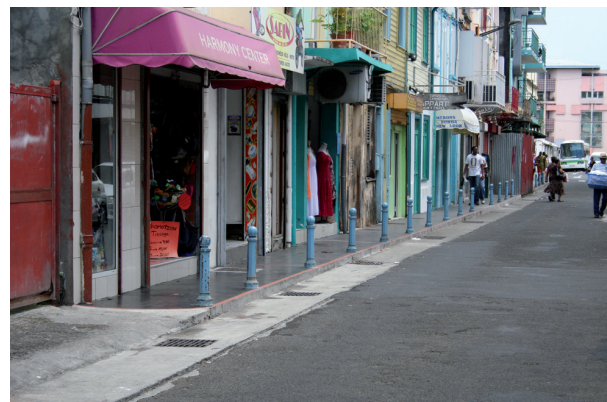
Réfection du trottoir et de la voirie
