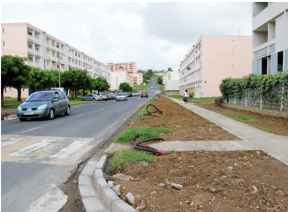
Travaux de réfection des trottoirs
